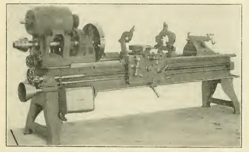
GEARED DRIVE FOR A LE BLOND ENGINE LATHE. MULTIPLE-AOLTAGE MOTOR.—BULLOCK ELECTRIC MANUFACTURING COMPANY.
