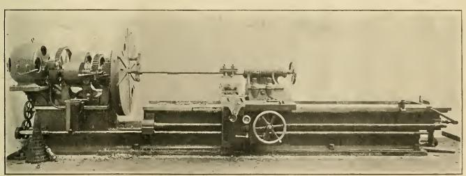
28-INCH—48-INCH EXTENSION GAP LATHE.—EDW. HARRINGTON, SON & CO. DRIVEN BY A 7½-H.P. MULTIPLE-VOLTAGE CROCKER-WHEELER MOTOR.
