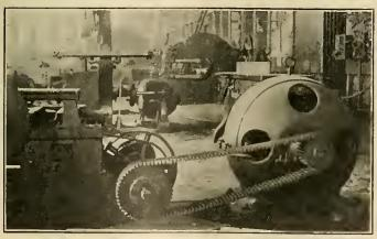
CHAIN DRIVE FOR A SAW IN THE TENDER DEPARTMENT OF THE BOLLER SHOP. MORSE BOCKER-JOINT CHAIN.
