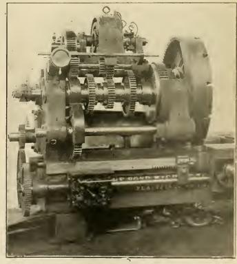
GEARED DRIVE UPON A 54-INCH LATHE.—POND MACHINE TOOL CO.
