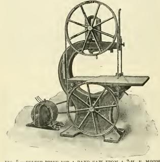
FIG. 5.—DELTED DRIVE FOR A BAND SAW FROM A 2-H. P. MOTOR.
