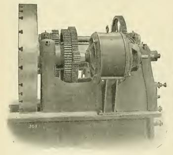
GEARED DRIVE FOR A FITCHBURG LATHE. MULTIPLE-VOLTAGE
