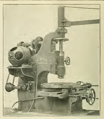
VERTICAL SPINDLE MILLING MACHINE,—NEWTON MACHINE TOOL CO. DRIVEN BY A 10-11.P. MULTIPLE-VOLTAGE CROCKER-WHEELER MOTOR.
