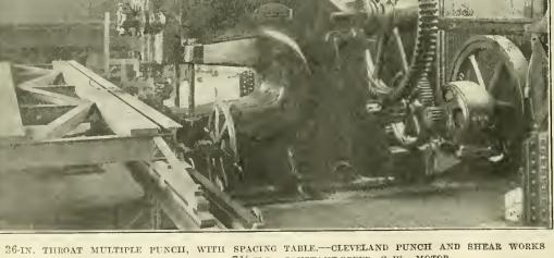
COMPANY. DRIVEN BY A 71/2-H.P. CONSTANT-SPEED C.-W. MOTOR.
