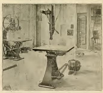
FIG. 4.—BELTED DRIVE FOR A JIG SAW FROM A 1-H. P. SLOW-SPEED MOTOR.
